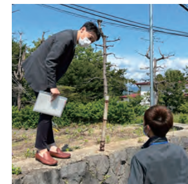
現場調査(市役所職員立会い)
